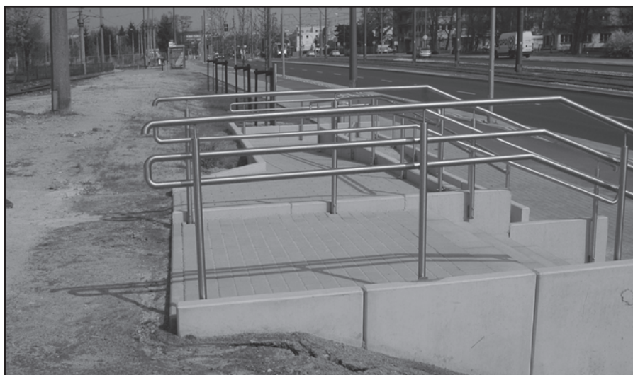
Piękne schody do nikąd – pętla na ulicy Budziszyńskiej
