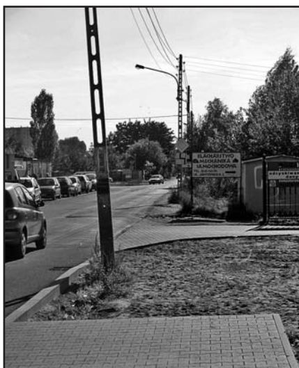
Niedokończony chodnik na ulicy Jawornickiej
